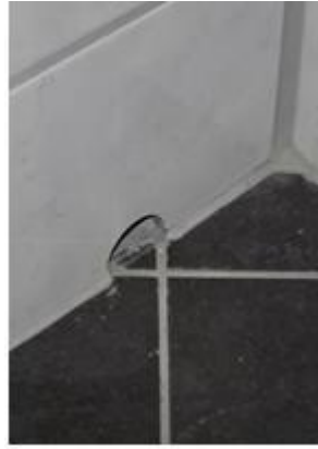
Figur 4 Lekkasjevarsler badrom
