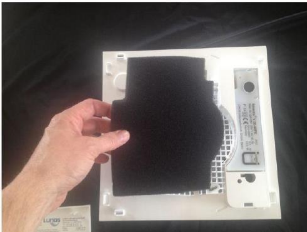
Figur 8 Ta ut det grå-sorte filteret (klasse G3-filter). Det kan vaskes, tørke og settes tilbake i ventilatoren. Filter bør sjekkes/vaskes/rengjøres 2-4 ganger i året. Støvmengde avgjør.
